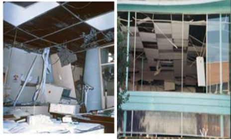
الشكل(6): آثار انهيار الاسقف المستعارة. [3]
