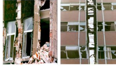
الشكل (8): أمثلة على انهيار مواد الإكساء الخارجي [3]
