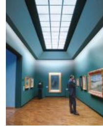
الشكل (8) الإنارة باستخدام الأسقف المضيئة.
