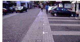
شكل (22): استخدام ارضيات خشنة من البازلت في الحارات المخصصة للمرور الالي كأحد الحلول لتهدئة سرعه السيارات مع تحديد اماكن انتظار السيارات بمادة ولون مختلف وإعطاء كل مكان مخصص لانتظار السيارات رقم خاص به.
